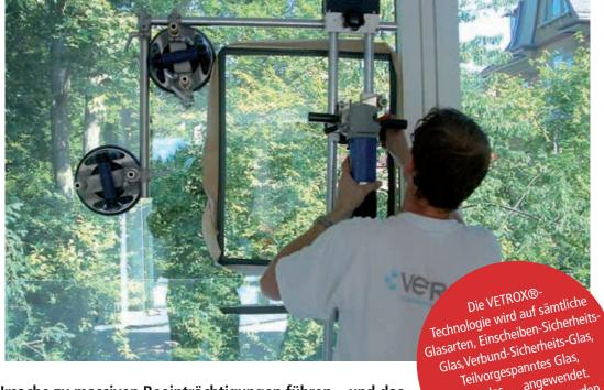
Bei grossen Glasflächen kann eine kleine Ursache zu massiven Beeinträchtigungen führen – und das wird teuer, wenn Scheiben ausgewechselt werden müssen. Hier kommt das europaweit patentierte VETROX®-Verfahren zum Einsatz: Es saniert Glasbeschädigungen jeder Dimension in höchster Qualität, denn die zu sanierenden Glasoberflächen werden vor Ort absolut plan geschliffen und poliert!
